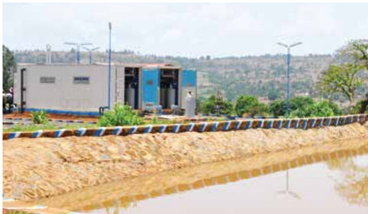
Marafiq dehidracija blata - 4 mobilne kontejnerske naprave 4x 8 m 3 /h, Jubail industrijska cona 1, Kraljevina Saudova Arabija
