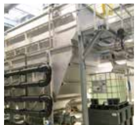
Industrijska odpadna voda
