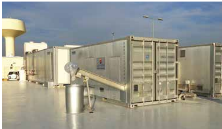
Sistem za obratno osmozo slane vode 300 m 3 /d , Moskva, Rusija
