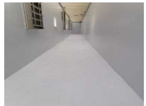
Filter Einlasskanal nach der Sanierung
