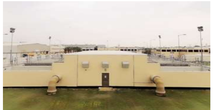
Rapid Sand Filters nach der Sanierung
