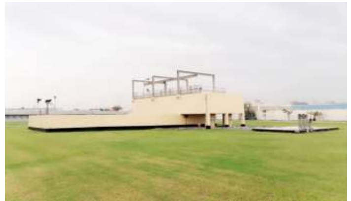
Tertiary Lifting Station nach der Sanierung
