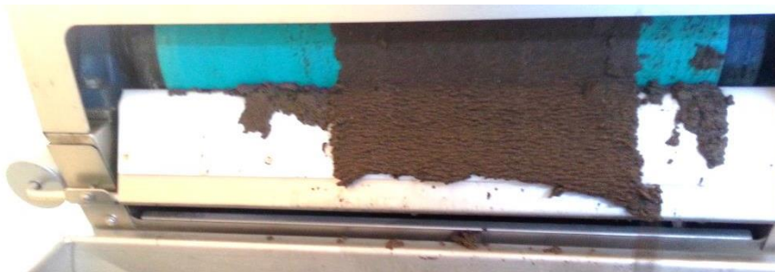
Schlammwässerung: Schlammkuchen der Siebbandpresse
